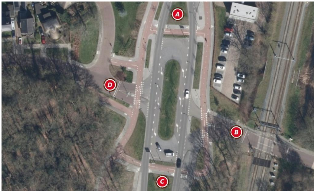
Figuur 4.13 Overzicht kruispunt Port Natalweg/Overcingellaan
