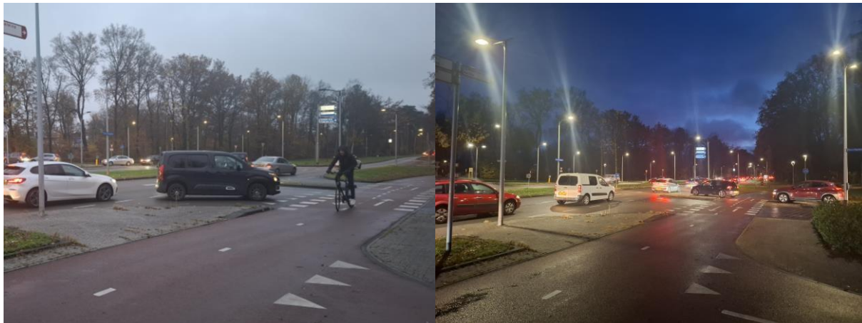
Figuur 4.14 Te kleine opstelruimte (beide afbeeldingen) en terugslag vanaf kruispunt WZA (rechts)
